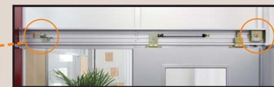
引戸クローザーと空圧装置による半自動引戸構造!!
